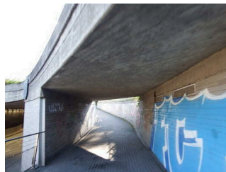
Bild von Europaradweg R1 – Tunnel Ortsdurchfahrt Wernigerode
