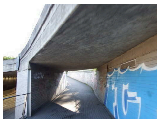
Bild von Europaradweg R1 – Tunnel Ortsdurchfahrt Wernigerode
